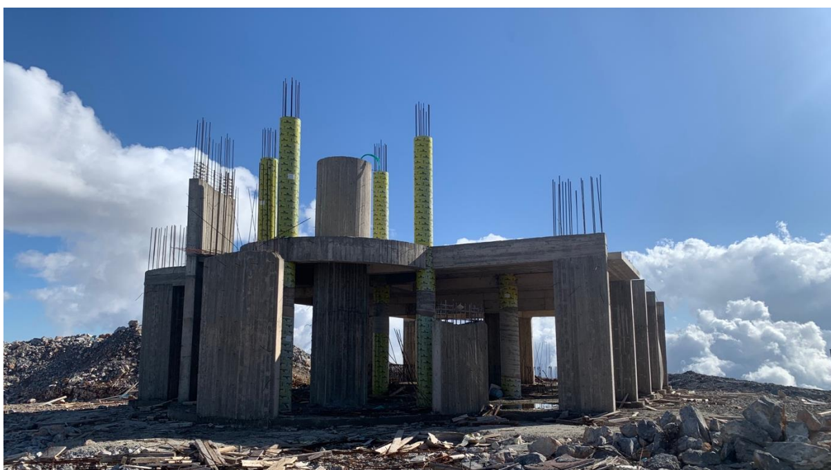
Το υπό κατασκευή κτίριο του «Αστεροσχολείου».
